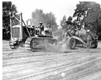
Véritable révolution d'origine américaine, le scraper va permettre d'aplanir le sol des rizières. Le recours à cet engin met fin à des décennies durant lesquelles la tâche a été effectuée à la pelle et à la pioche.
