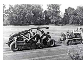
Véritable révolution d'origine américaine, le scraper va permettre d'aplanir le sol des rizières. Le recours à cet engin met fin à des décennies durant lesquelles la tâche a été effectuée à la pelle et à la pioche.
